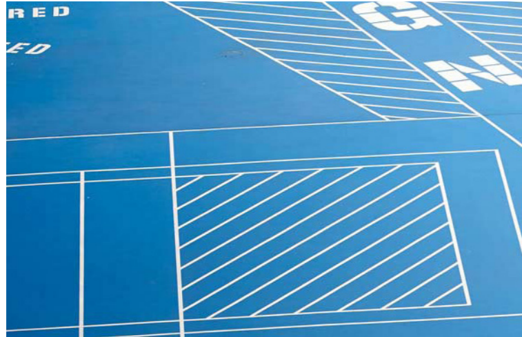
Покрытие из резиновой крошки с разметкой RAL 5012, RAL 2012
